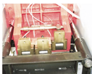
DWA TŁOKI PRACUJĄ, PRAWY ZABLOKOWANY.
